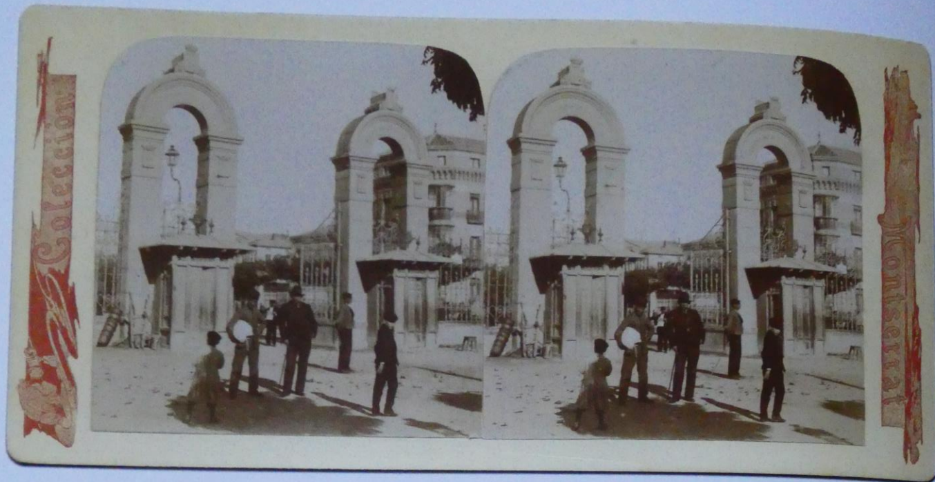
80. Puerta de Santa Engracia, poco antes de su demolición Colección FBS, Madrid
