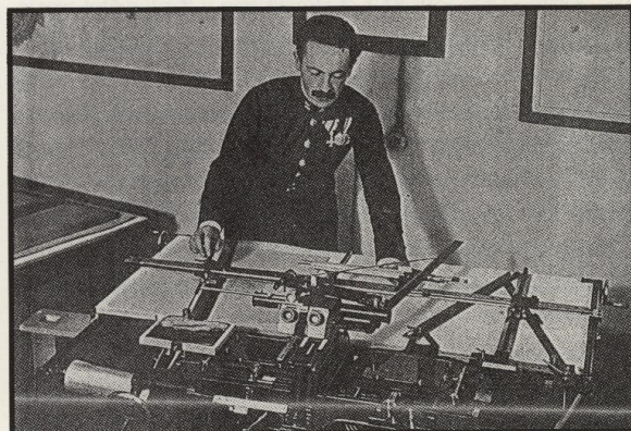
E. von OREL Y EL ESTEREOAUTOGRAFO CON EL ESTEREOCOMPARADOR
